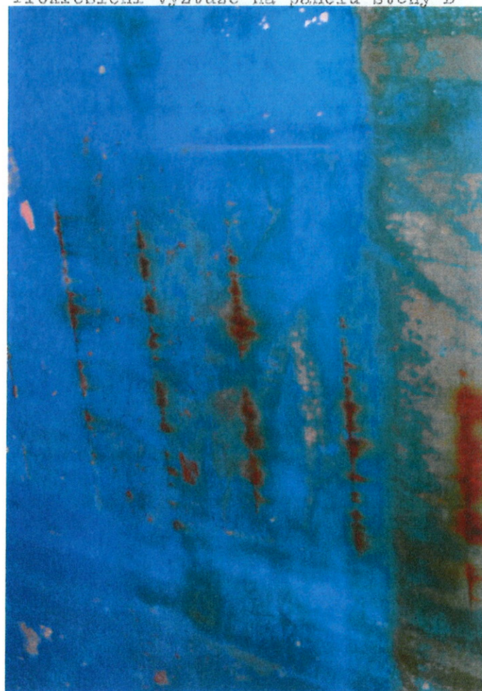
Prokreslení výztuže na panelu stěny D
